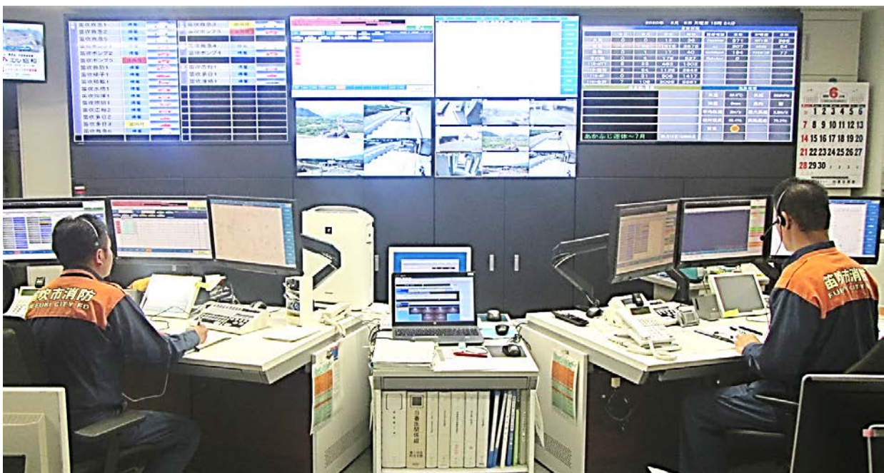
笛吹市消防本部 高機能消防指令センター
