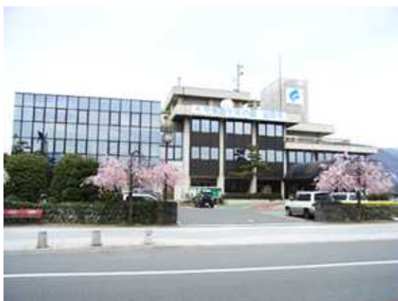
市役所本庁舎(耐震改修実施前)
