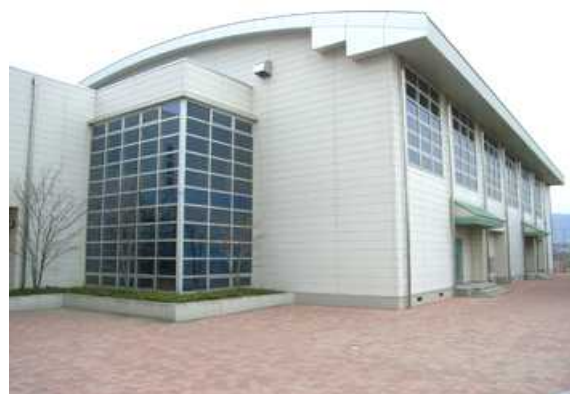
石和西小学校(体育館)
