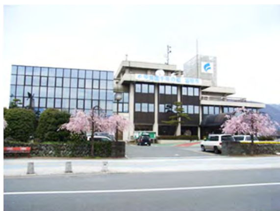
市役所本庁舎(耐震改修実施前)
