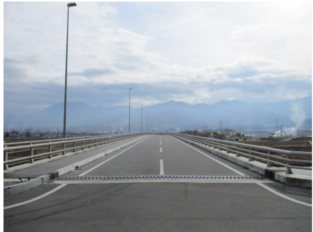
完成した砂原橋（右岸側から）
